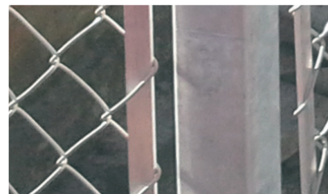
Fletvævet er grå (ral 7030) PVC ekstruderet, der består af varmgalvaniseret kernetråd og PVC plastbelægning i dimension Ø3,1 mm.
