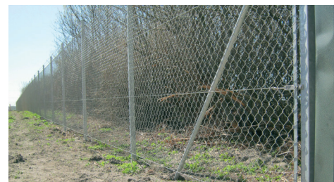
Firkantstolpe 60 x 60 x 3 mm, fremstillet iht. EN 20219/1+2 sættes i beton styrke 16 til frostfri dybde.
